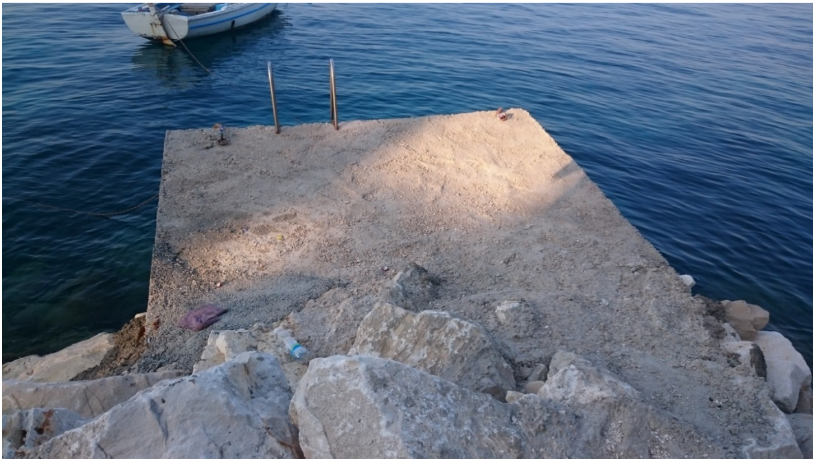
Slika 1.1.-5.: Betonska konstrukcija na vrhu saniranog zaštitnog pera (Zeleni servis, kolovoz 2018.)
