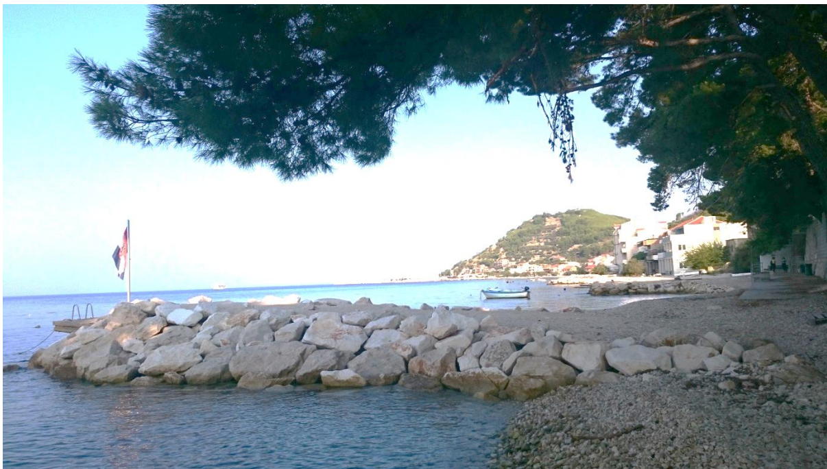
Slika 1.1.-4.: Izgled saniranog zaštitnog pera (Zeleni servis, kolovoz 2018.)
